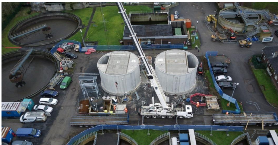
Oibreacha Suiteála Sloda Iompórtáilte & Umair Sloda Biotáille - Gléasra Cóireála Dramhuisce Chathair Chill Chainnigh & an Cheantair Máguaird
